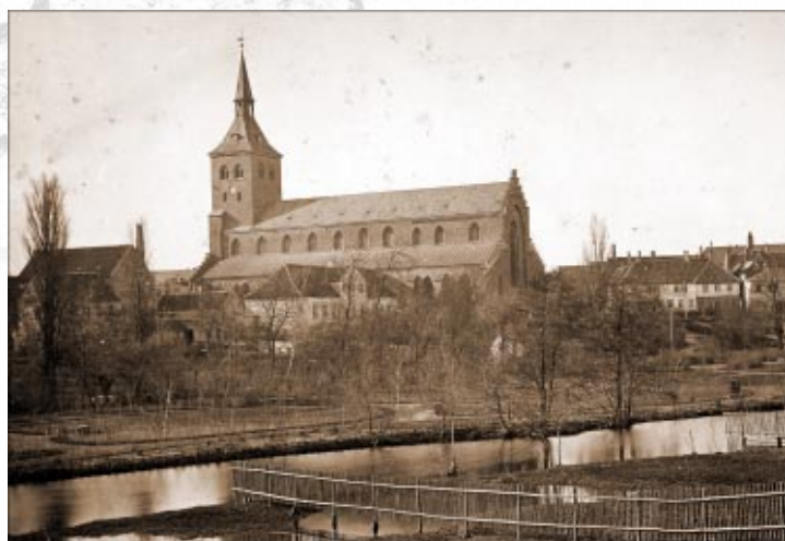
Udsigt fra Kronprinsensgade mod Skt. Knuds Kirke og Kloster ca. 1880. Det ses tydeligt, hvordan sydfløjen er blevet afkortet, så den ikke længere er sammenbygget med konsistoriebygningen (østfløjen). Sydfløjen fik i 1864 påført en ekstra etage. Op ad hegnsmuren mod klostergården og op ad sydfløjens østfacade var der bygget mindre, lette bygninger i form af skure og stalde.
