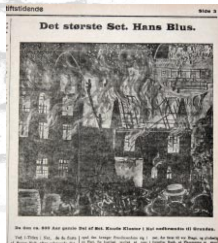
Fyens Stiftstidende bragte dagen efter branden en tegning af begivenhederne. Ilden havde godt fat i tagværket, der blev flammernes bytte. Branden gik hårdt ud over tilbygningerne, mens mange af de gamle klostermure overlevede, hvorfor spørgsmålet om en restaurering snart blev rejst.
